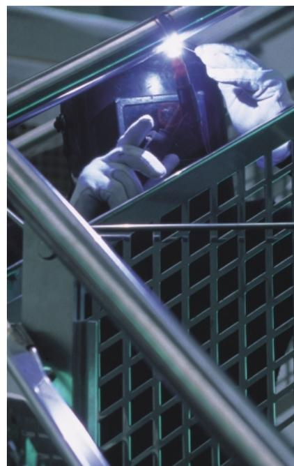
Bild 9: WIG-Schweißen eines Edelstahlgeländers
